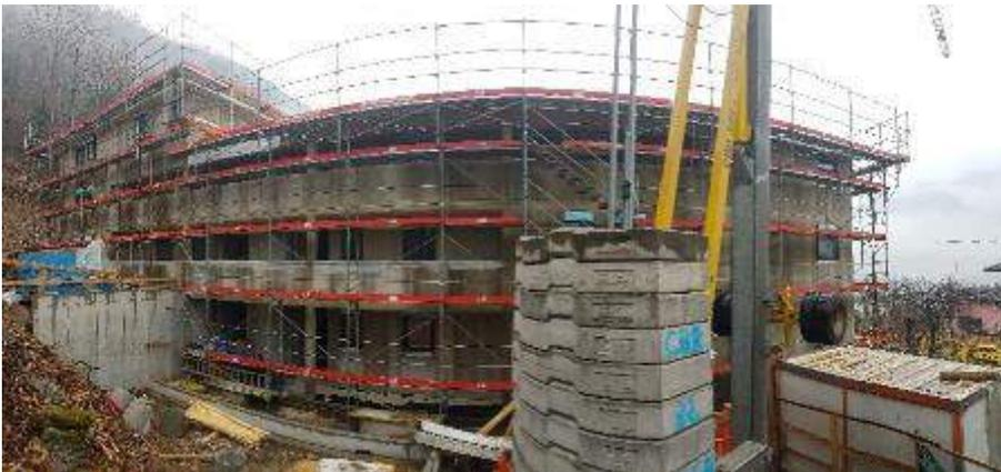
Das Wohnhaus beherbergt 15 Wohnungen und verfügt über eine Tiefgarage und 3 Etagen. Es ist in zwei, in der Höhe versetzte Körper unterteilt, welche miteinander durch ein zentrales Treppenhaus und Stahlbetonaufzug verbunden sind.
