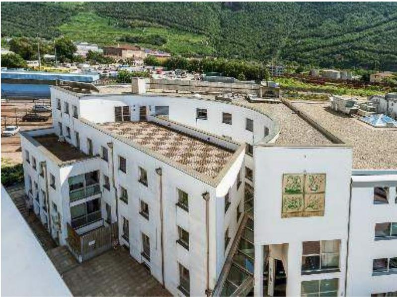
Das bestehende Tragwerk war geeignet, Belastungen nur von zwei Stockwerken in Leichtbauweise zu widerstehen. Es war daher notwendig, mit einem vorgefertigten Holzbausystem zu arbeiten, um zusätzliche Belastungen einzuschränken. Weiterhin war es notwendig, eine energieeffiziente Gebäudehülle zu realisieren.
