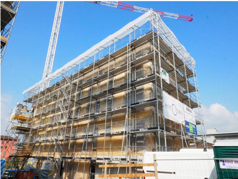
Die Wände sind in Ständerbauweise und die Decken aus Holzträgern.
