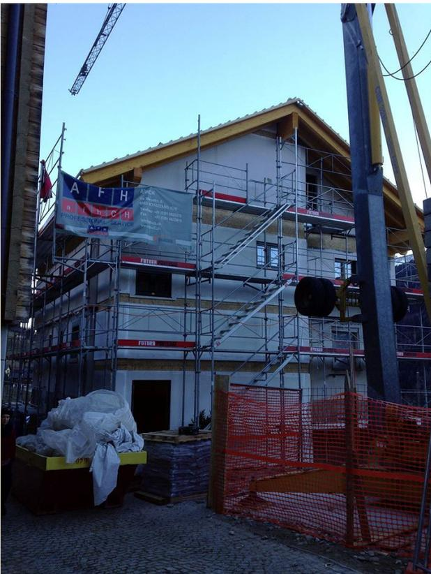
Das Gebäude wurde zwei Stockwerke über die gesamte Fläche aufgestockt und drei neue Wohneinheiten wurden errichtet. Das gesamte bestehende Gebäude wurde energetisch saniert.
