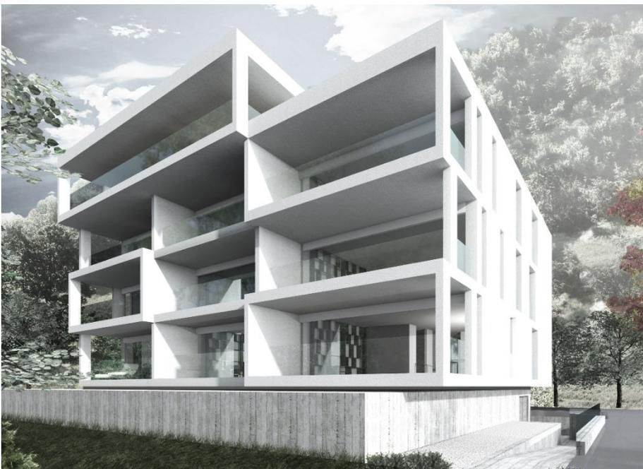
Die Besonderheit des Projekts sind die bemerkenswerten Spannweiten von über 6,7 m als Einfeldträger berechnet,
